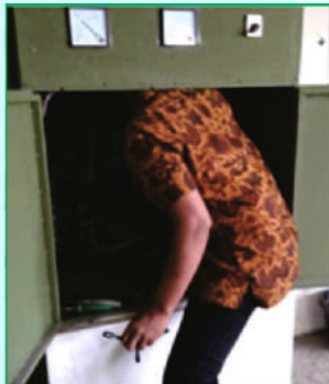
Pemantauan dan perbaikan jaringan listrik
