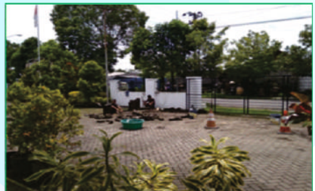
Perbaikan paving halaman untuk mengantisipasi dampak banjir saat hujan deras
