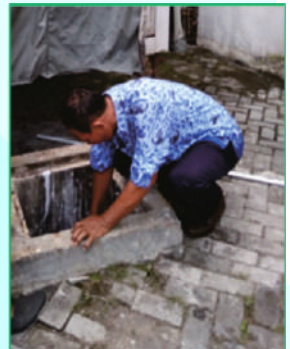
Pemantauan dan perbaikan jaringan air bersih
