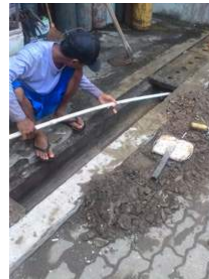
Perbaikan saluran drainase di halaman belakang
